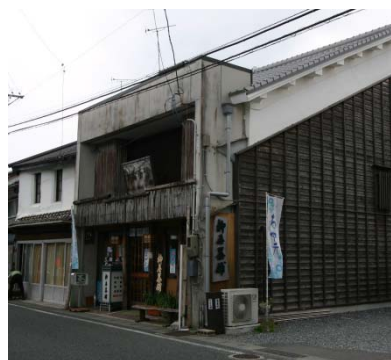
■工事前-パラペットで内部が確認できない
