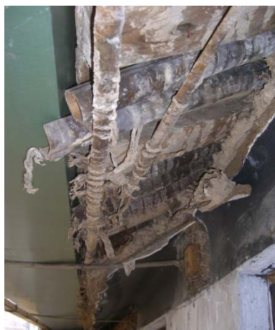
■工事中・パラペット内部の軒先
