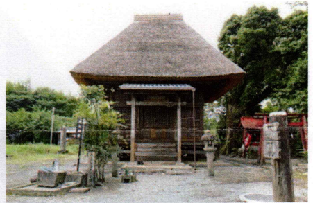
下里御大師堂(工事後)
