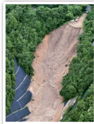
廃棄された土石の崩落により 死者1名、重傷者1名 住宅被害1棟
