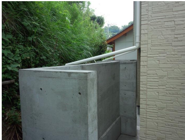
(参考)防護壁タイプの施工事例
