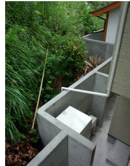
(参考)防護壁タイプの施工事例
