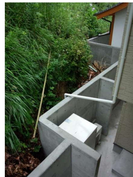
(参考)防護壁タイプの施工事例
