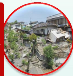
住宅の被災状況
