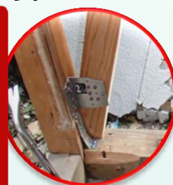
柱脚筋かい金物
