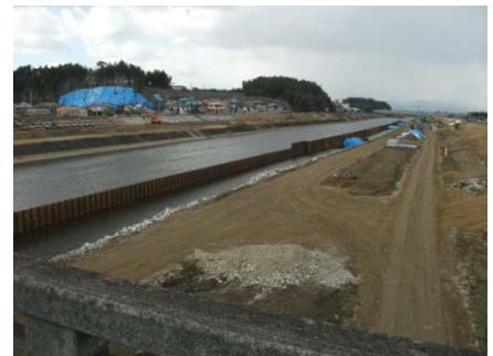
河川被害も酷く緑川、秋津川、御船川、その川に架かる橋が通行止め、復旧工事の目途もたたない状況が続いています。現在御船川両岸の堤防を3kmにわたり改修している状況です。
