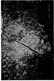
② 練造擁壁の亀裂
