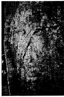
① 宅地地盤の亀裂
