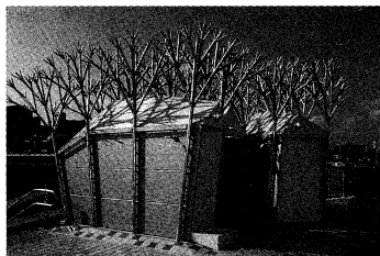
白川橋左岸緑地トイレ
